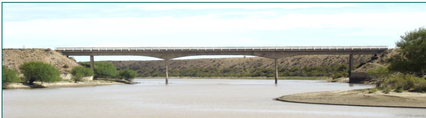
Figura 10 - Imagen Google del puente, donde se observa el banco aflorante que observamos el día de la medición.
